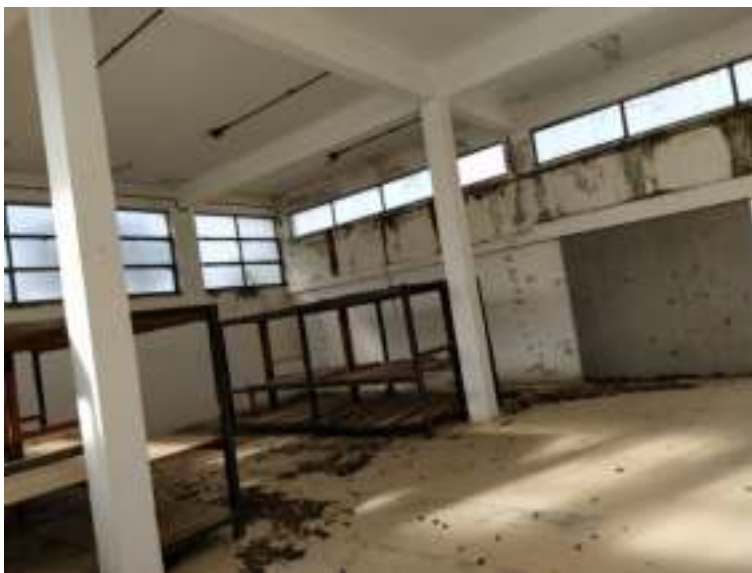
Ενδεικτικές εσωτερικές λήψεις κτίριου Κ1 (ισόγειο αριστερά, όροφος δεξιά)
