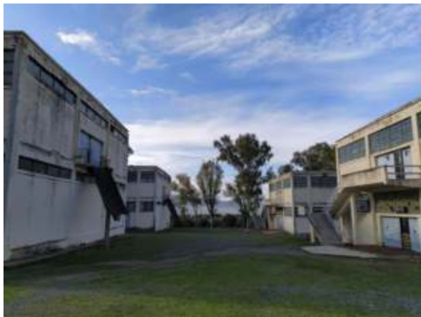
Γενικό πλάνο κτιρίων Κ1-Κ4 και ενδιάμεσος υπαίθριος χώρος – Λήψη από Βορρά προς Νότο
