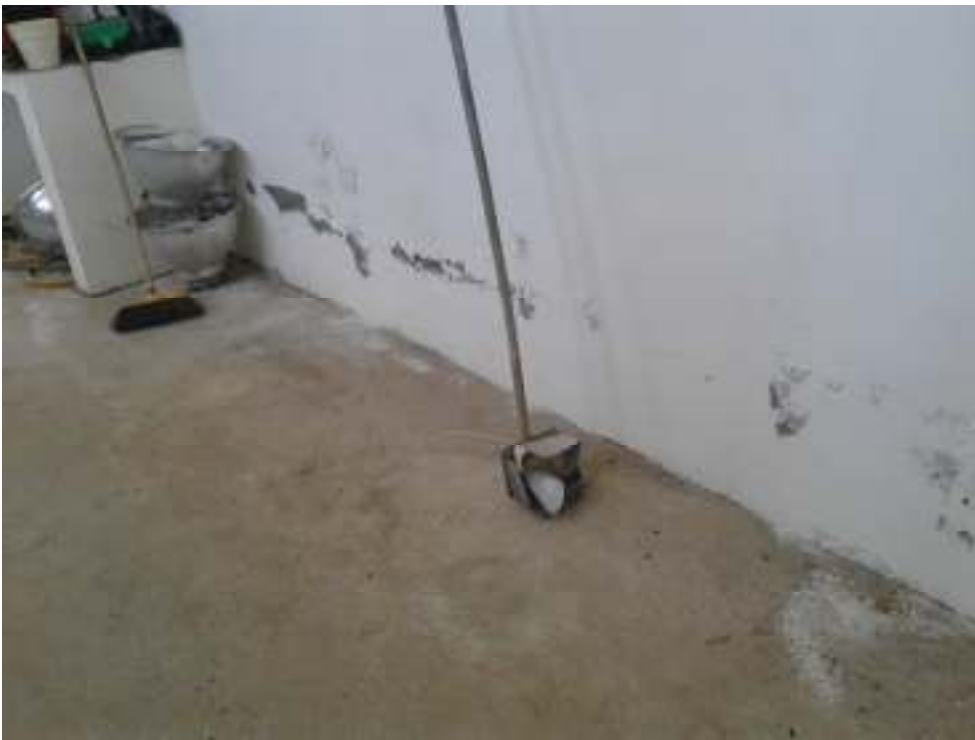
Φωτογραφία 3. Εσωτερικά λεβητοστάσιο.
