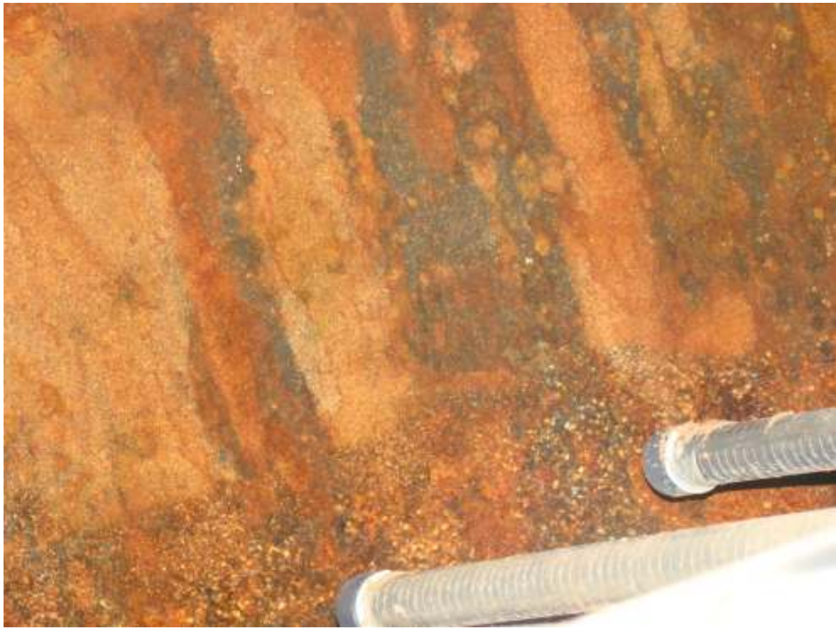
Εικόνα 15: Εσωτερική επιφάνεια χαλύβδινων φίλτρων
